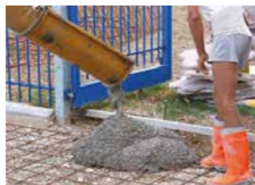
getto e staggiatura del calcestruzzo
