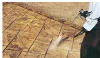
dopo alcuni giorni... lavaggio con idropulitrici e successiva resinatura idrorepellente antiolio
